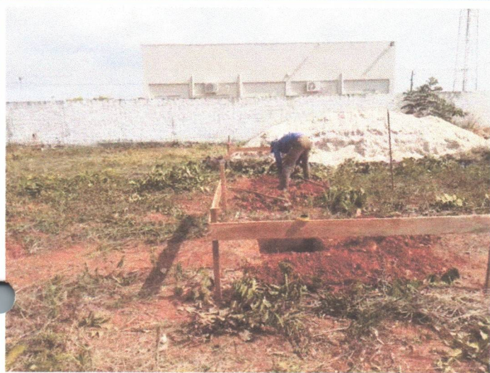
ESCAVAÇÃO MANUAL DE VALA
