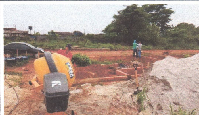
ESCAVAÇÃO DAS SAPATAS
