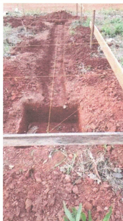
ESCAVAÇÃO DAS SAPATAS
