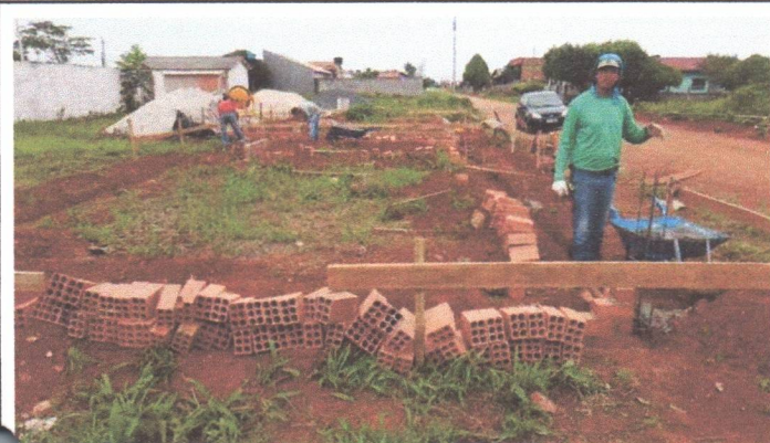
ESCAVAÇÃO DAS SAPATAS
