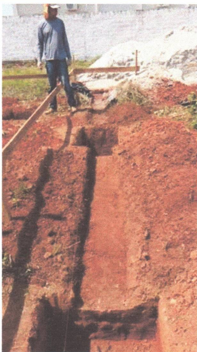
ESCAVAÇÃO DAS SAPATAS
