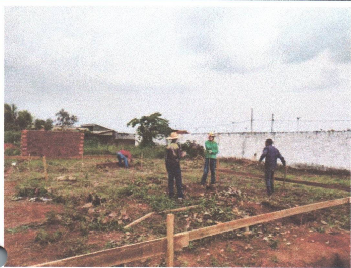
ESCAVAÇÃO DAS SAPATAS
