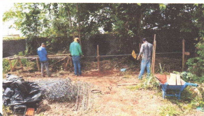
ARMAÇÃO DE PILAR OU VIGA E ALVENARIA
