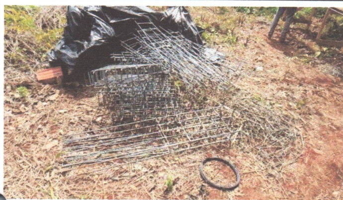
ARMAÇÃO DAS VIGAS BALDRAMES
