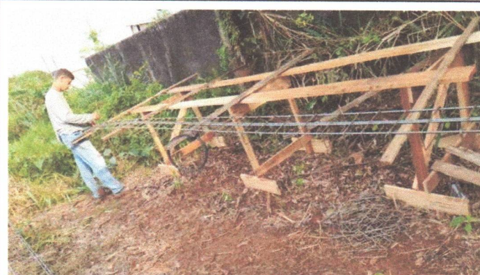
ARMAÇÃO DE PILAR OU VIGA E ALVENARIA
