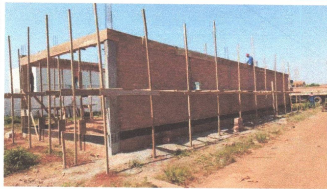
ALVENARIA, ARMAÇÃO VERGAS CONTRA VERGAS
