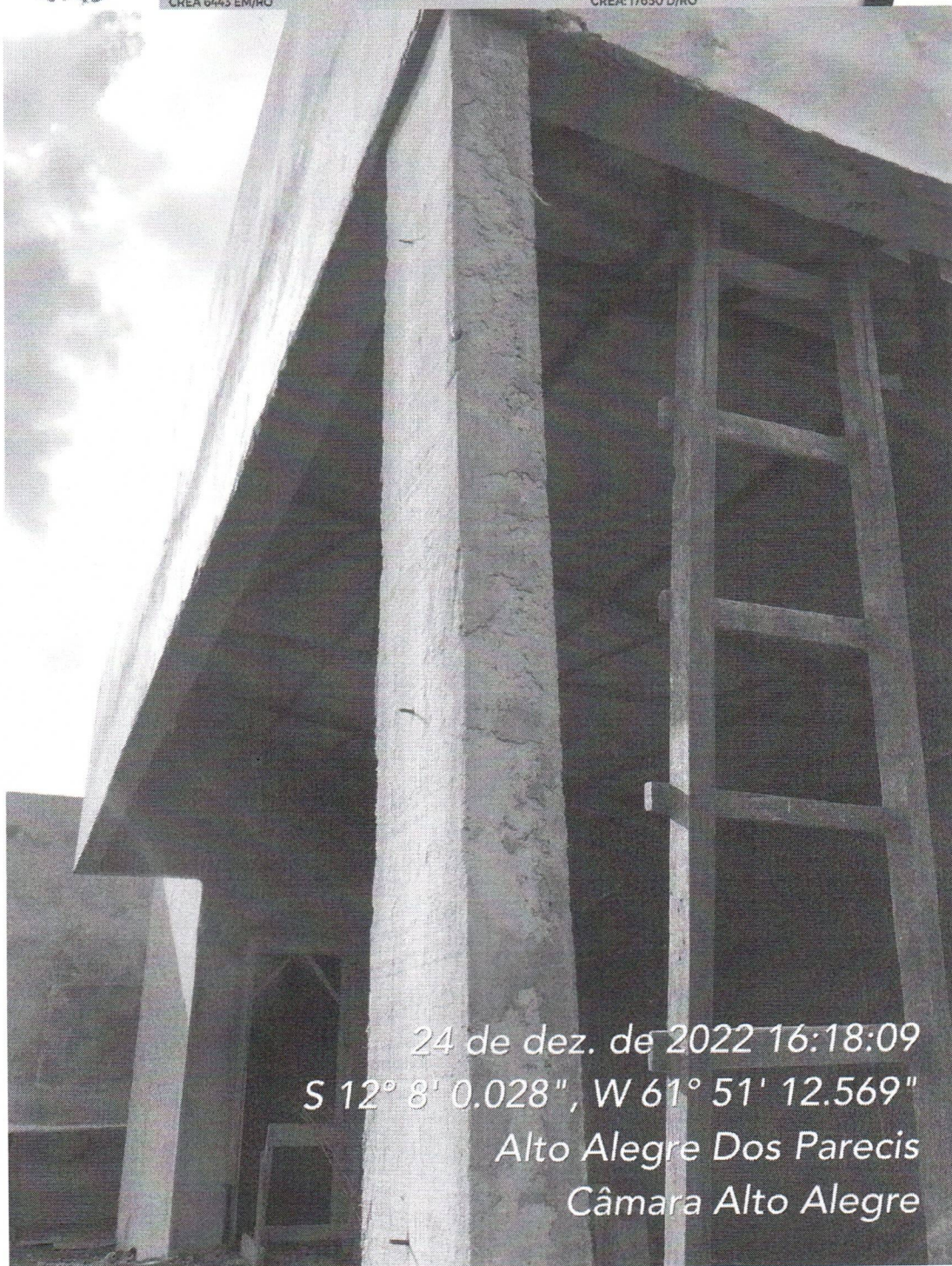
Figura 11 – Concreto do pilar P16 mal adensado.
