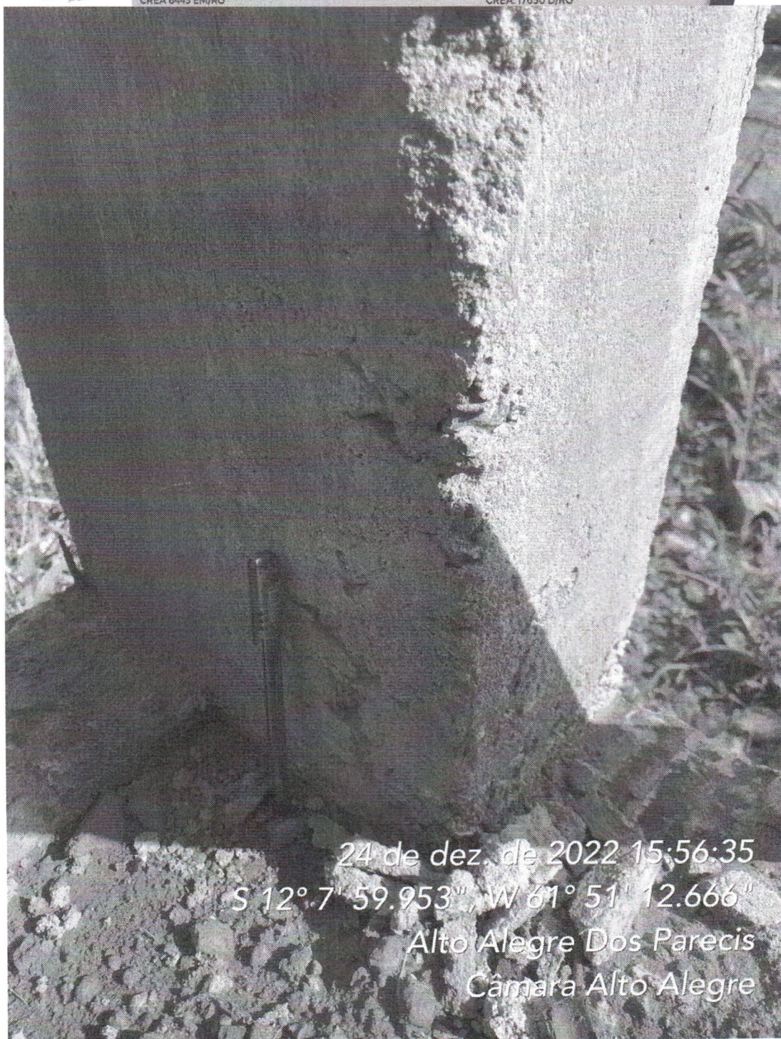
Figura 10 – Concreto do pilar P16 mal adensado.
