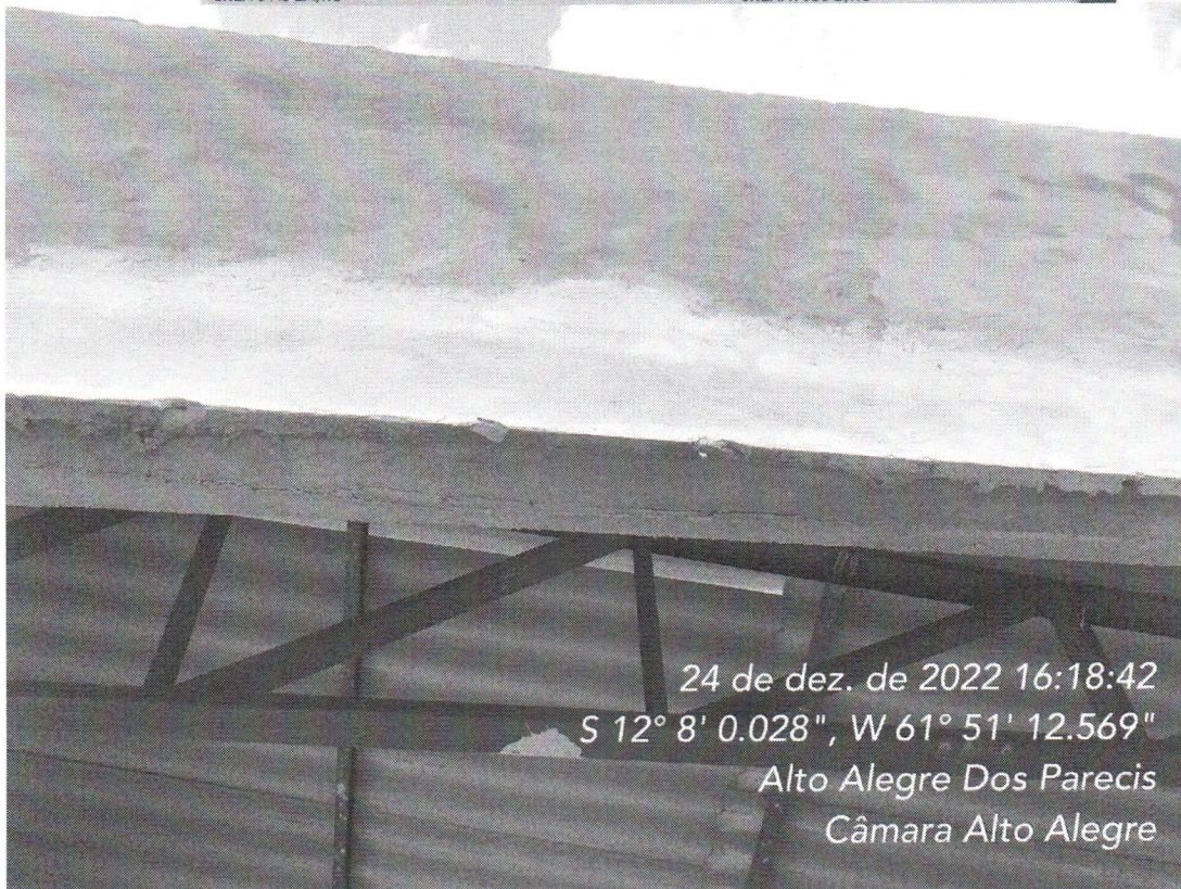
Figura 07 – Desagregação no eixo longitudinal na viga VR9.
