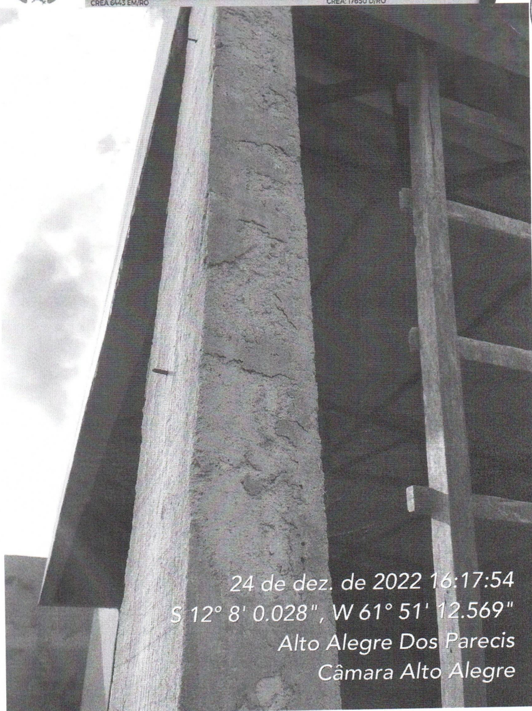
Figura 12 – Concreto do pilar P16 mal adensado.
